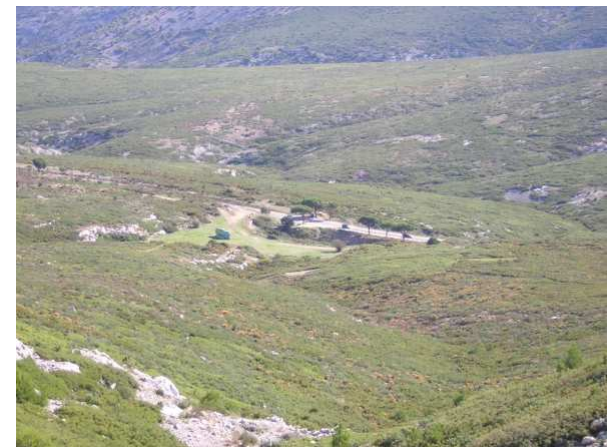
Citerne DFCI, route de la Ginsete — (GIP des Calan-
